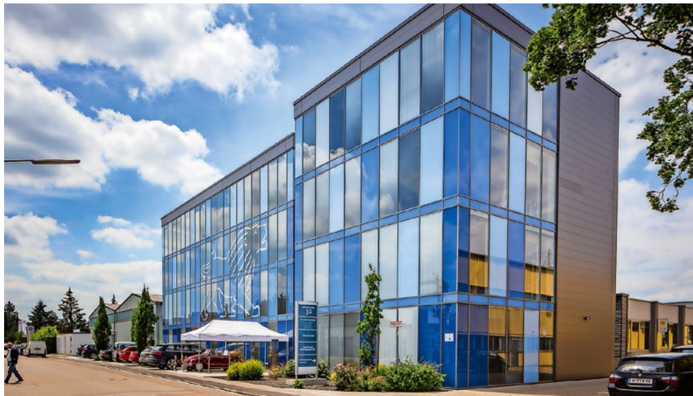
Das neue Verwaltungsgebäude von S+P Samson in Kissing.
