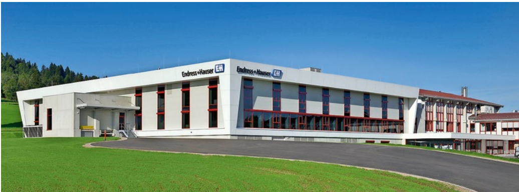
Der Neubau von Endress + Hauser Wetzer in Nesselwang ist architektonisch und energetisch durchdacht.
