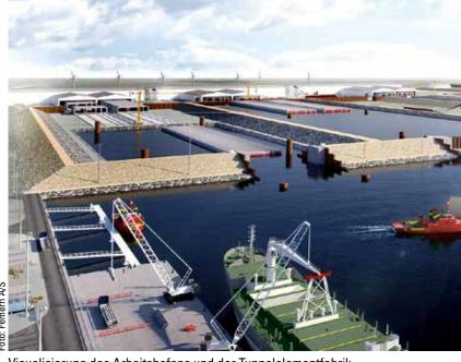
Visualisierung des Arbeitshafens und der Tunnelelementfabrik
