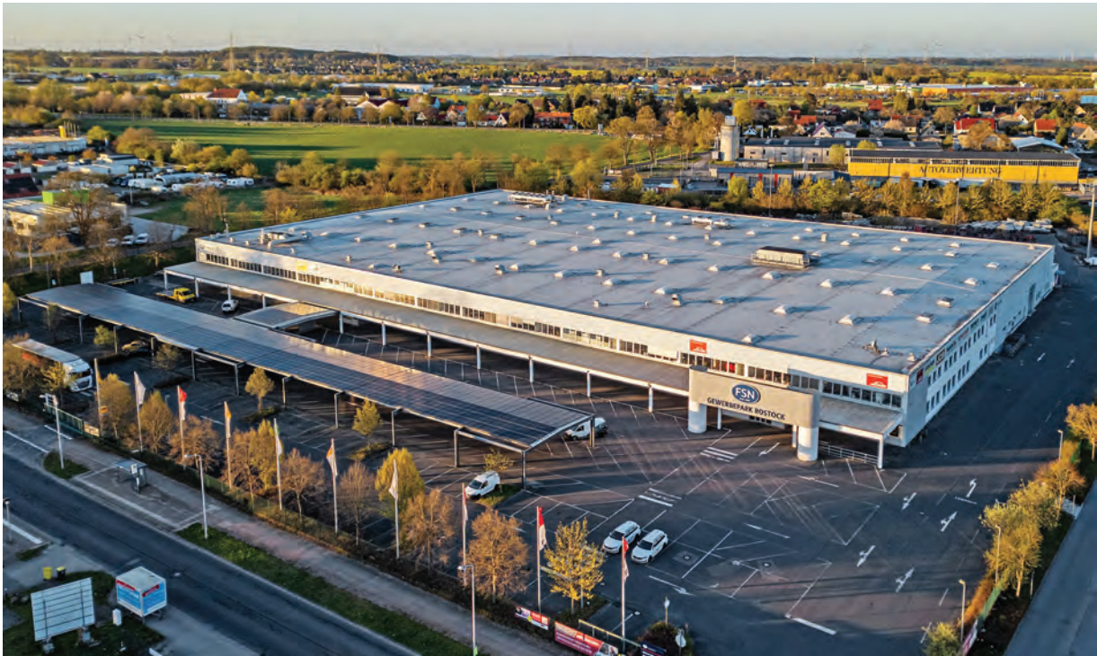
Ob Hubwagen, Gabelstapler, Exoskelette, Elektroautos oder Fahrräder: Die Rostocker FSN Unternehmensgruppe – hier im Bild der FSN Gewerbepark – ist ein breit aufgestellter Mobilitätsanbieter.
