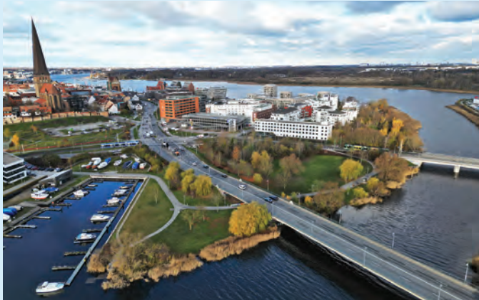
Die Vorpommernbrücke in Rostock muss saniert werden.
