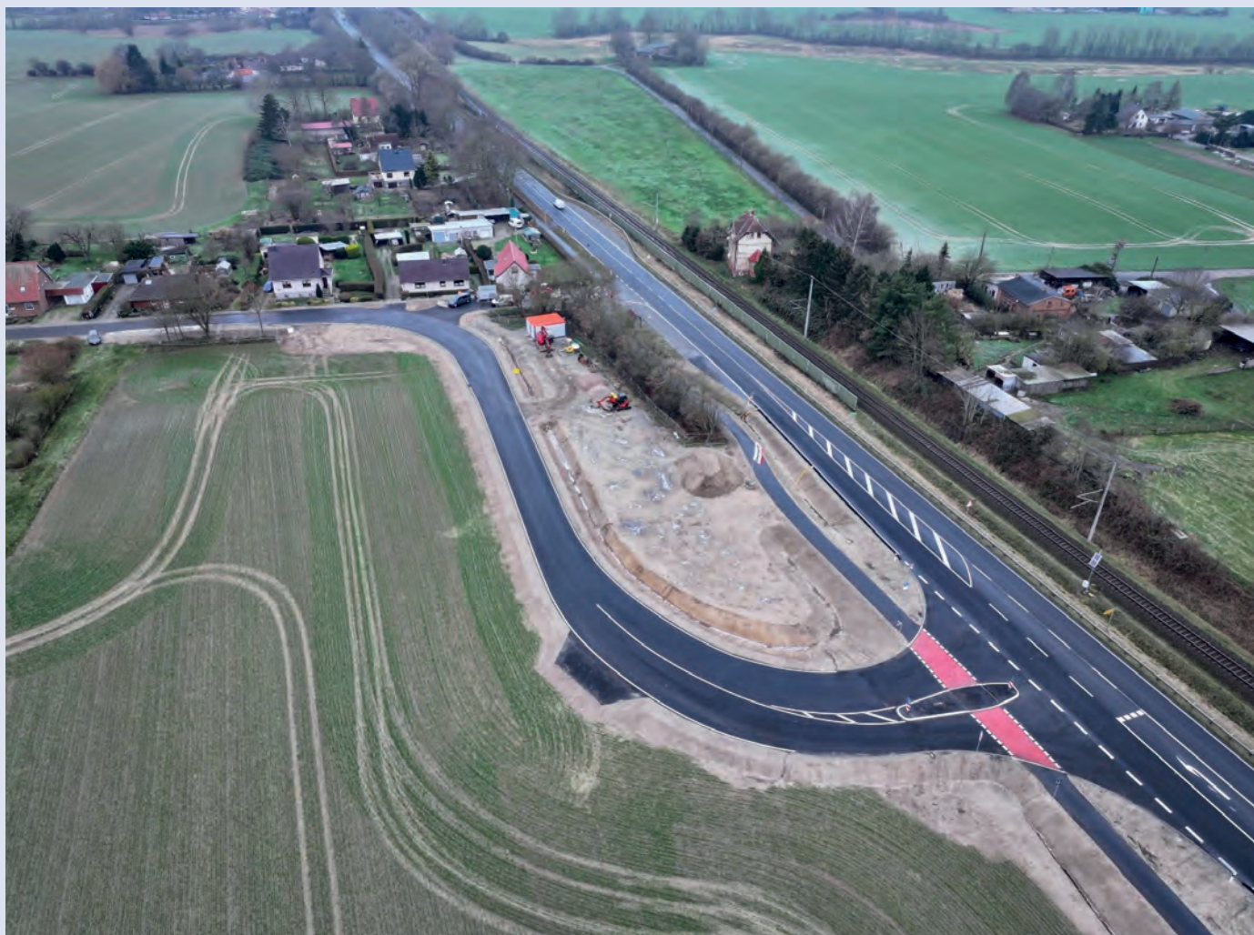
Bei der Umgestaltung des B105-Knotenpunktes Pütte wurde erstmals ein Straßenbauprojekt in MV komplett digital geplant, der Bauablauf begleitet und dokumentiert.
