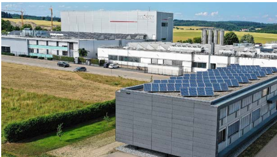
Das Firmengebäude von Weisser in Neresheim. Fotos: Weisser
