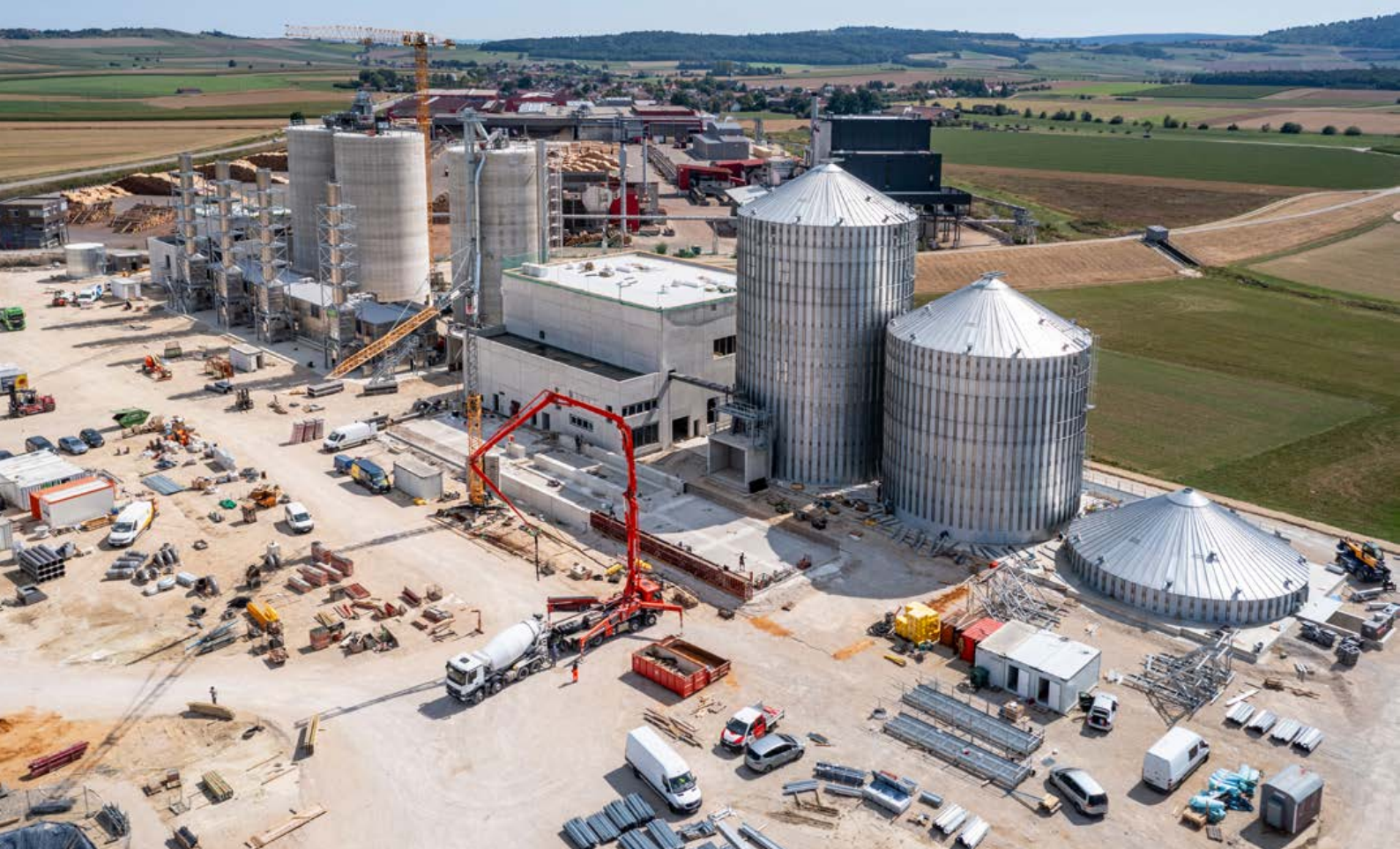
Derzeit entsteht die neue Pelletproduktion in Kerkingen. Fotos: Ladenburger/projektteam H. Mzyk
