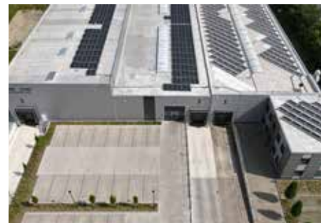
Fotos: Oberbremer Baubetriebe
