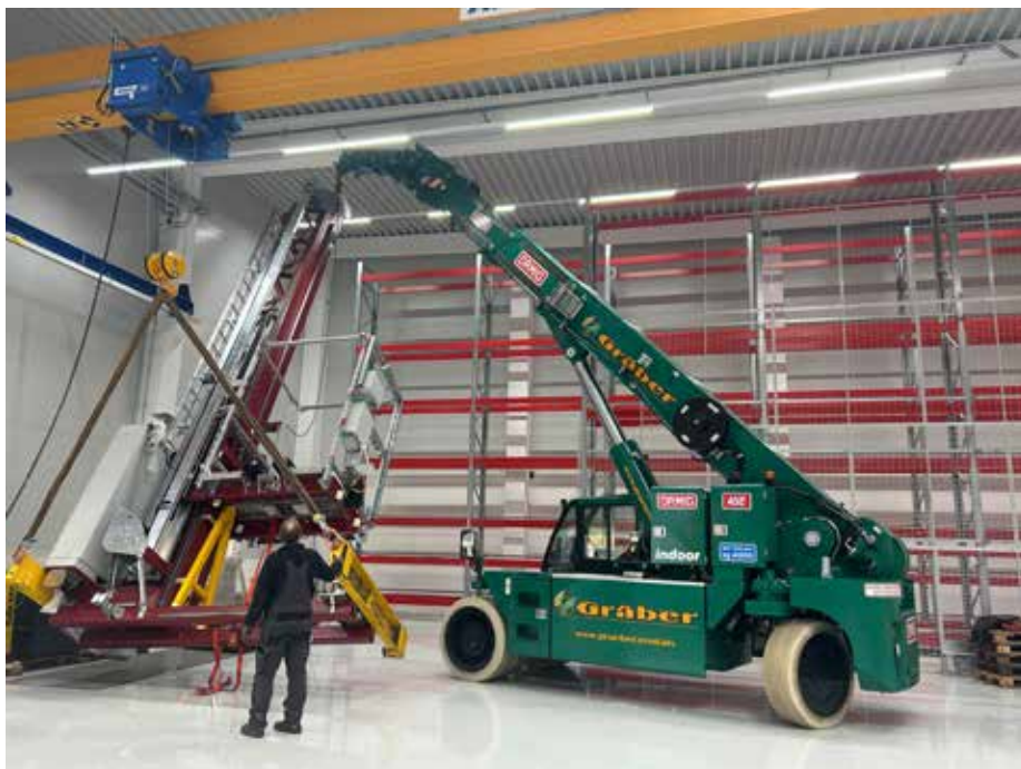
Präzisionsarbeit mit Leichtgewicht: Das moderne Einmast-RBG für das 8,9 Meter hohe, integrierte Lager der Heppner GmbH CNC-Technik wurde per Normaltransport geliefert und mit Mobil- und Hallenkran eingebracht.
