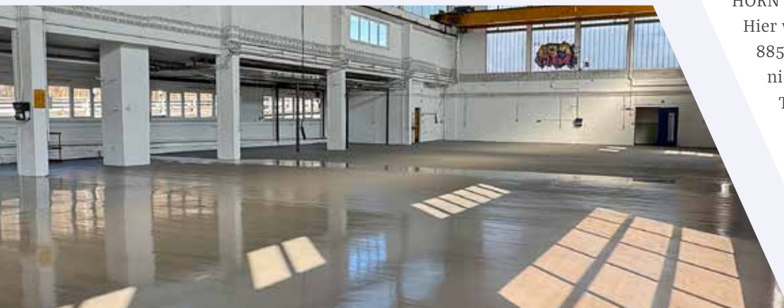
Fertige Fläche bei Firma PORR in Seevetal
