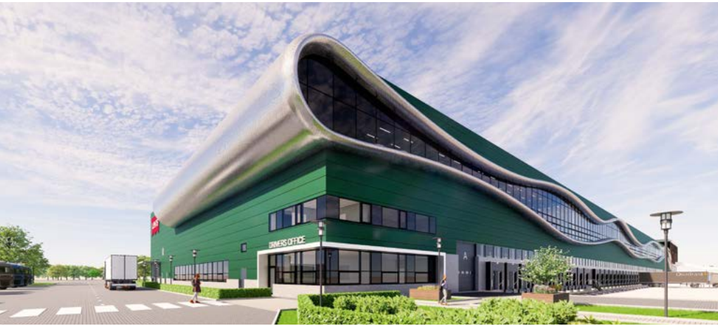
Im April 2024 wird das Distributionszentrum, hier eine Visualisierung, in Betrieb gehen. Von hier wird dann der europäische Markt versorgt.
