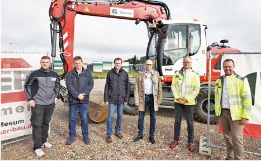
Lucas Roosmann und Norbert Steingröwer vom Bauunternehmen Büscher, André Reinke von der EWG Rheine, Werner Limbers von der Planungsgruppe Mesum sowie Volker Böckmann und Michael Borcharding von Giesecke (v. l.) am neuen Standort. Foto: Büscher
