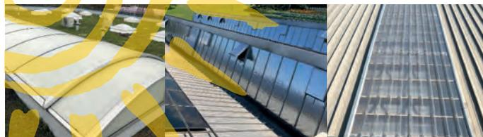
Liquisol 4EVERblue ist eine speziell entwickelte Flüssigkeit, die als Sonnenschutz auf Kunststoffoberflächen, wie zum Beispiel Lichtkuppeln, Pergola- oder Wintergartendächern, Lichtbänder oder auf rauen Glasoberflächen aufgebracht wird. Wie bei unseren Sonnenschutzfolien wird auch mit 4EVERblue ein effektiver Hitze- und Blendenschutz erzielt.
