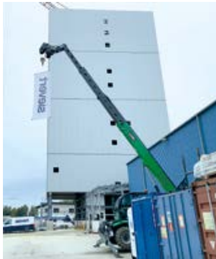
Der Neubau der Sievert SE in Mamming umfasst eine Bauhöhe von 45 Metern.
