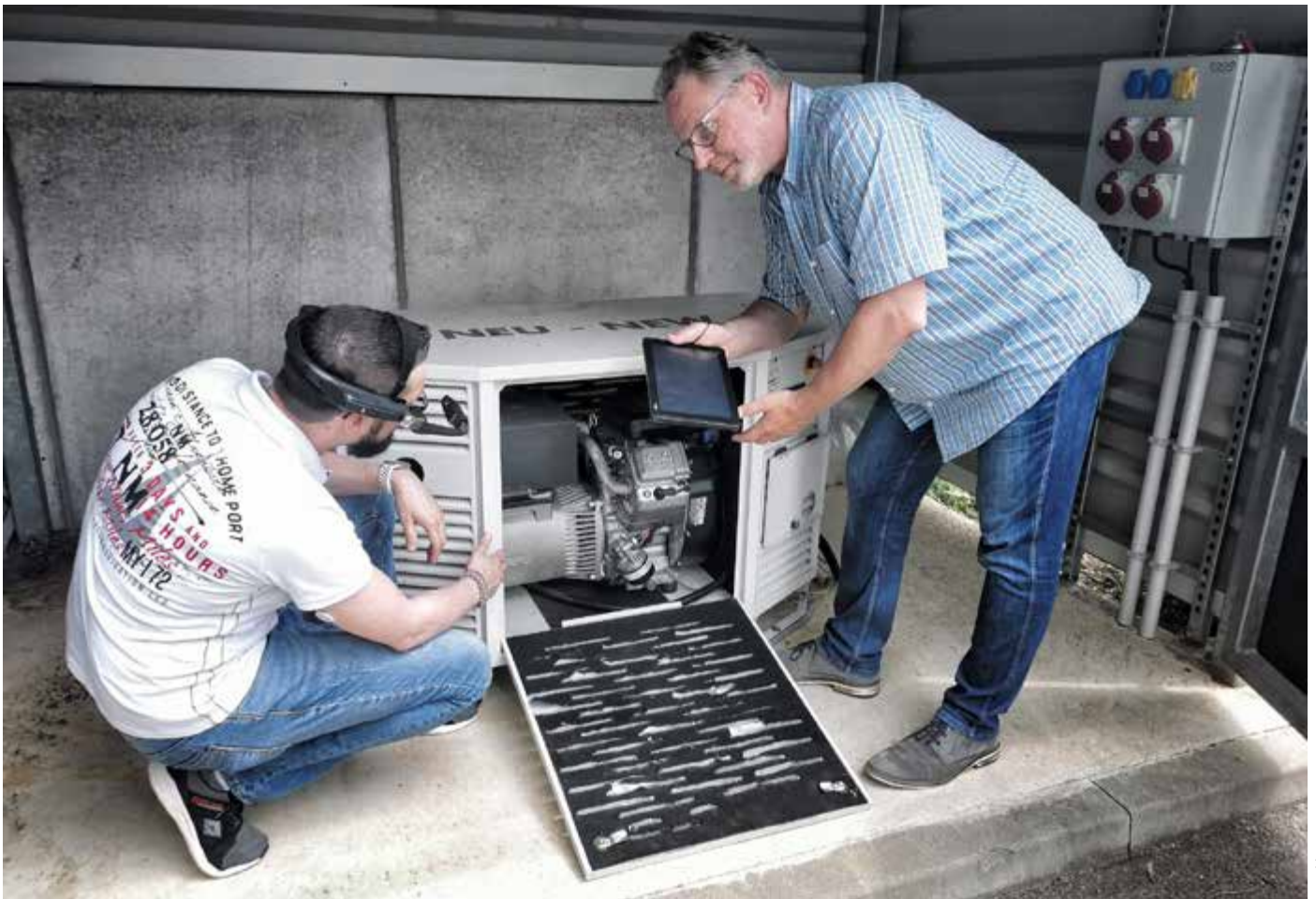
Erprobung verschiedener Endgeräte während der Wartung eines Notstromgenerators bei der GESA Automation GmbH
