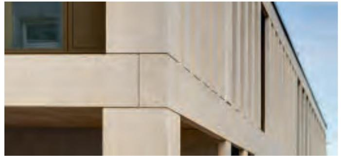
Teile der Realisierung dieses Projektes sind durch HERING Architectural Concrete umgesetzt worden. Idee des Architekten und Bauherren war es, aus dem Altbau zurückgewonnene mineralische Baustoffe ortsnah zu recyceln und für den Neubau wiederverwerten zu können.
