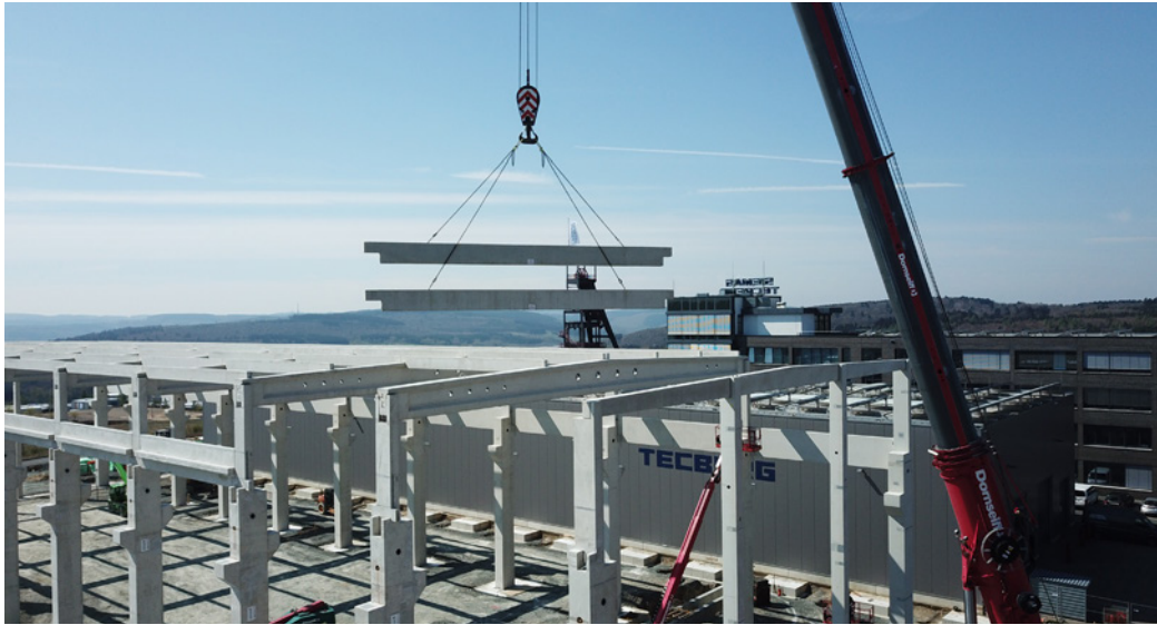
Hallenkonstruktion mit einer Höhe von 18 m.
