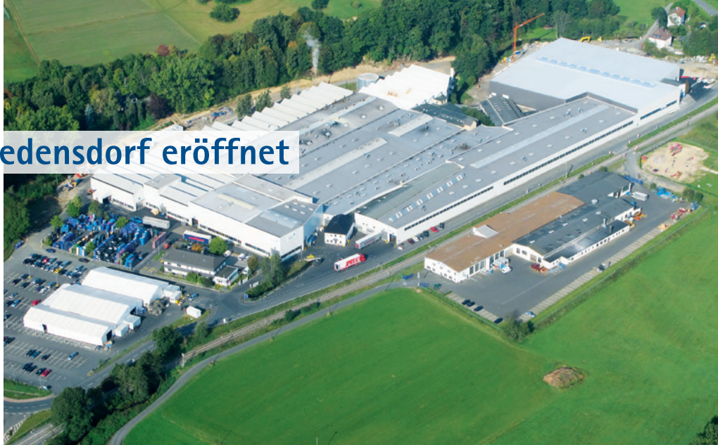
Das neue Areal bietet Raum für künftige Innovationen, Kapazitätserweiterungen und Wachstum.
