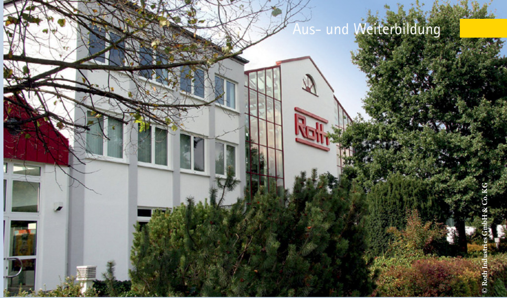
Das Roth-Atrium in Buchenau: Hier wird auch zu kulturellen Veranstaltungen eingeladen.
