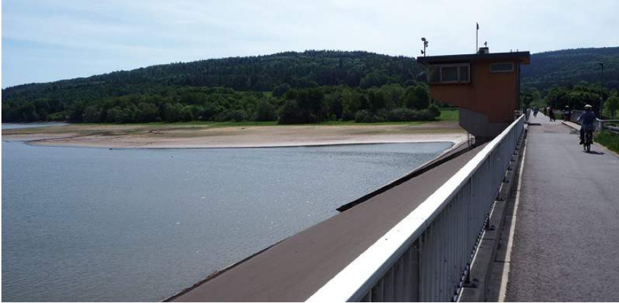
Naturschutz, Hochwasserschutz und Naherholung verknüpft: Die Kinzigtalsperre präsentiert sich mit einem aktuell „trockenen“ See.
