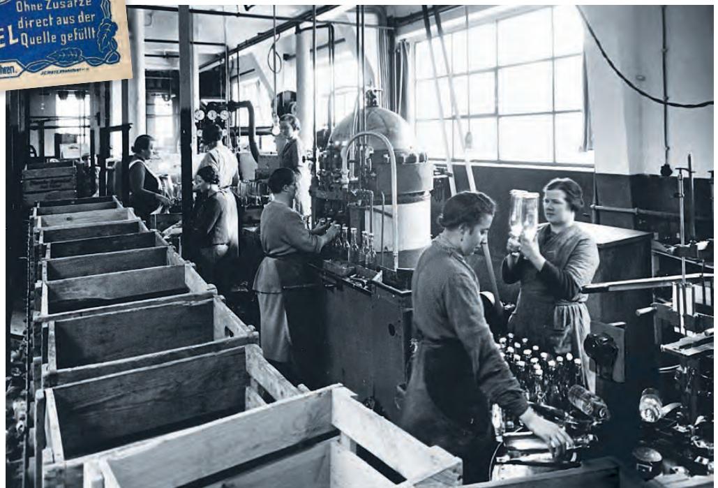
Die Hassia-Füllhalle Ende der 1920er-Jahre: In der Mitte drückt die Mitarbeiterin die Hebelverschlüsse auf die gefüllten Flaschen, rechts führt eine Kollegin eine Sichtkontrolle durch.
