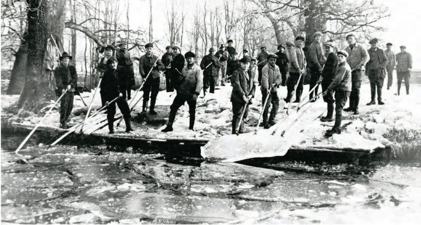
Eisschlagen zum Kühlen von Bier in der Brauerei
