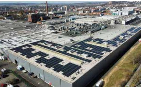
Die Solarfläche auf dem Dach des Reifenwerks in Fulda umfasst insgesamt 2397 Quadratmeter
