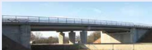
B27 Überführungsbauwerk der L 3378 bei Fulda-Lehnerz, erster Einsatz von UHFB (ultrahochfester Beton) in Deutschland im Straßenbrückenbau
