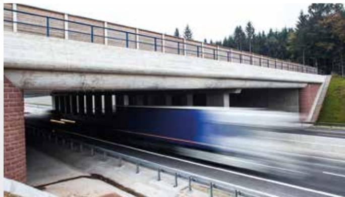
In der Grünbrücke auf der A4 zwischen Bad Hersfeld und Friedewald wurden insgesamt 6300 Kubikmeter Beton und 1020 Tonnen Betonstahl verbaut
