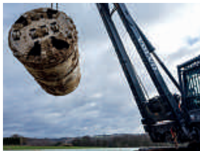
SaarGrundbau: Microtunneling und Spezialtiefbau. Foto: Volker Wiciok
