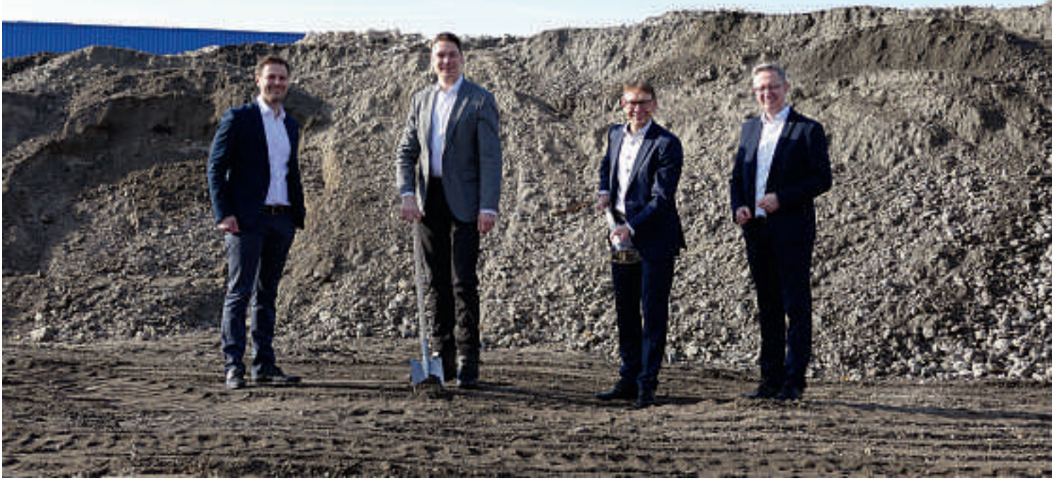
(v.l.): Bei strahlendem Sonnenschein setzen Geschäftsführer Alexander Böcker, Werkleiter Juri Sagiev, Bürgermeister Lothar Christ und der Leiter der Wirtschaftsförderung Matthias Stiller den offiziellen Spatenstich für die Baumaßnahmen an der Lippestraße.
