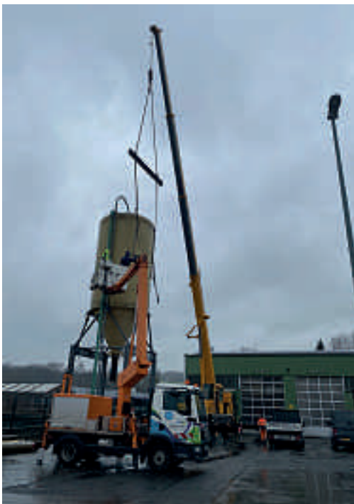
Abbau des alten Salzsilos auf dem Betriebsgelände der Stadtwerke in Westick.
