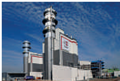
Trägt zur Versorgungssicherheit bei: das Trianel Gaskraftwerk.
