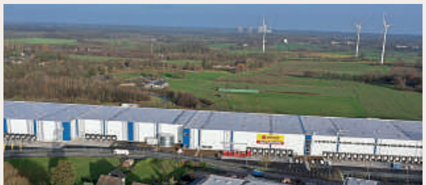
Gigantisch wirkt der POCO-Komplex auf dem 60.000-Quadratmeter großen Grundstück in Bönen.
