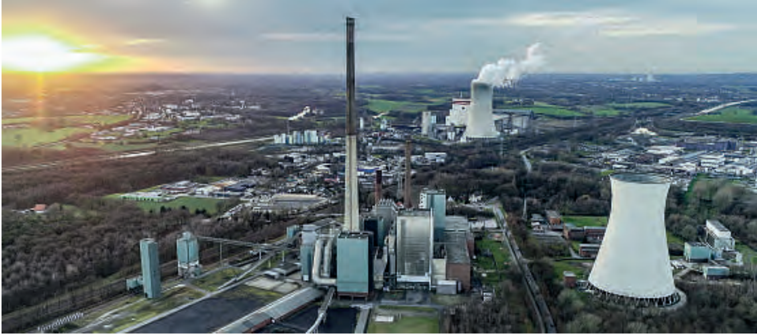
Die Luftaufnahme zeigt die gigantische Fläche des Kraftwerkareals.
