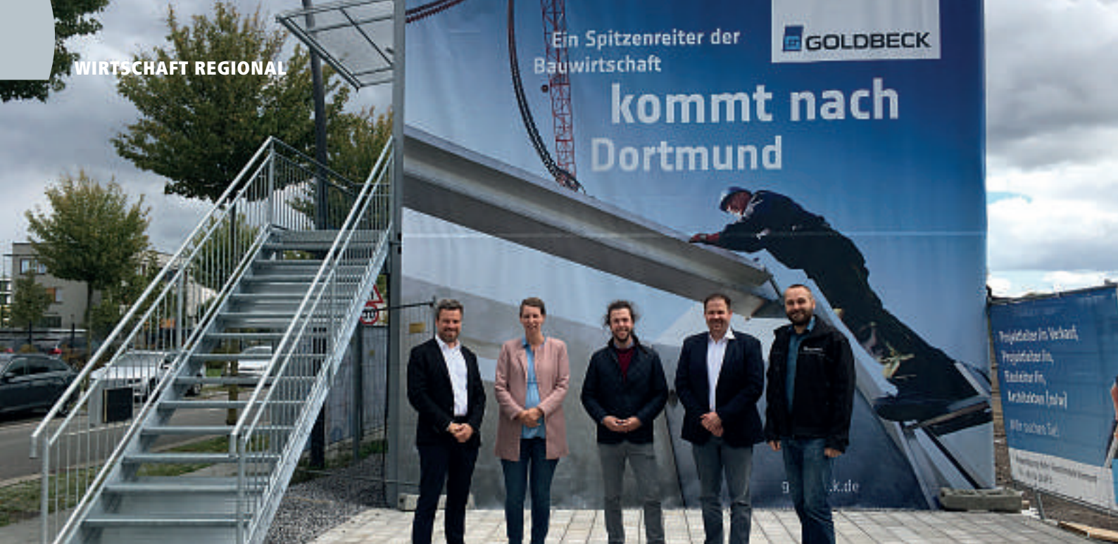
Thorsten Schenk (l.), Leiter der Goldbeck-Geschäftsstelle Dortmund, sitzt mit seinem Team bis zur Fertigstellung des TMM-Forums in einem Bürocontainer auf dem Baufeld.
