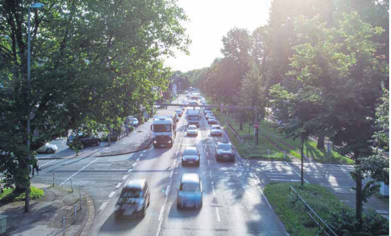
Blick auf die B 1 Richtung Osten: Der Abschnitt von der B 236 bis zur Märkischen Straße soll untertunnelt werden.
