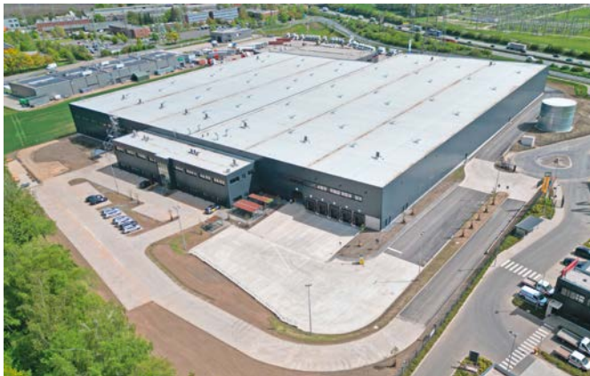
Der neue europäische Hauptsitz von Barnet Europe befindet sich in Eschweiler.
