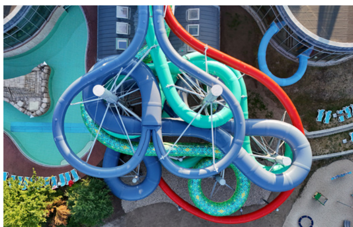
Acht Millionen Euro sind in eine neue Rutschen-Welt und die Sanierung der stark beanspruchten technischen Anlagen investiert worden.
