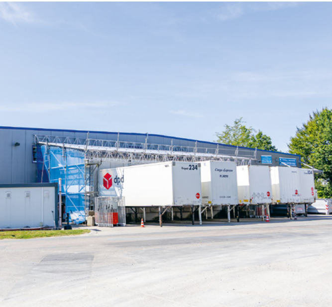
Logistikzentrum der Voss GmbH &amp; Co. KG in Viöl
