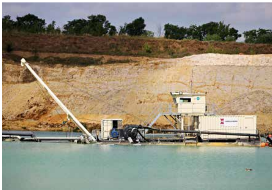
Im Nassbereich arbeitet ein Schneidkopf-Saugbagger bis in Tiefen von 20 Metern.
