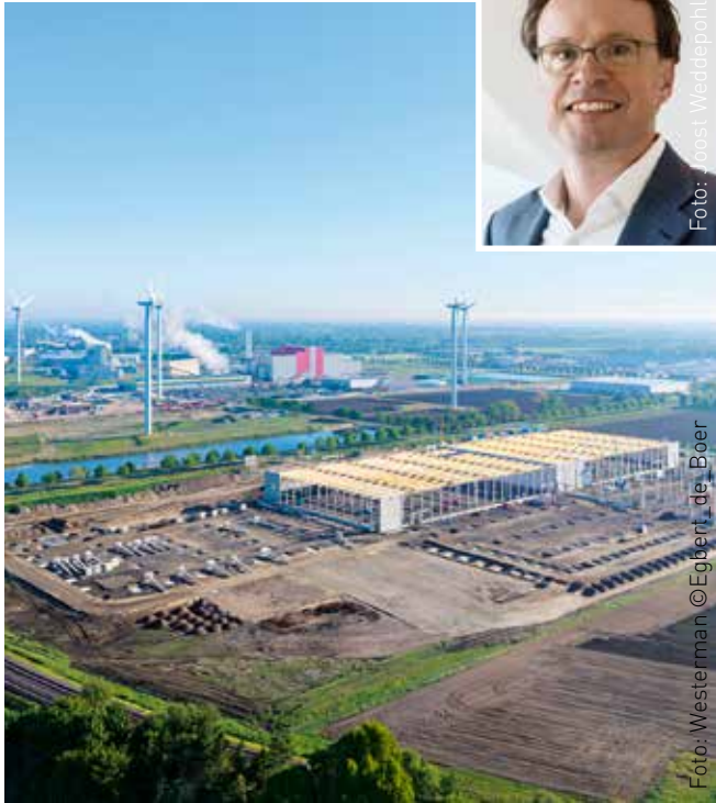
Im GVZ Europark baut die Westerman Multimodal Logistics einen Logistik-Hub mit 55 000 qm Lagerfläche (kl. Foto: Rutger-Jan van Broekhoven).
