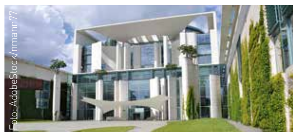
„Entlastungen in die Praxis bringen“: Unser Foto zeigt das Bundeskanzleramt in Berlin.
