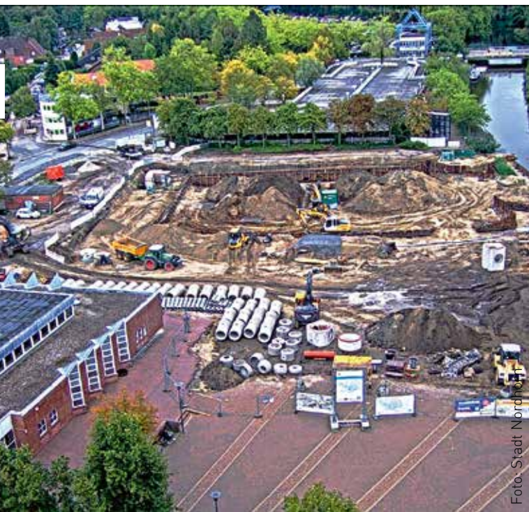
Attraktive Stadtzentren entscheiden mit über den Erfolg einer ganzen Region. In Nordhorn laufen derzeit die Bauarbeiten für den neuen Stadthafen in Nordhorn.
