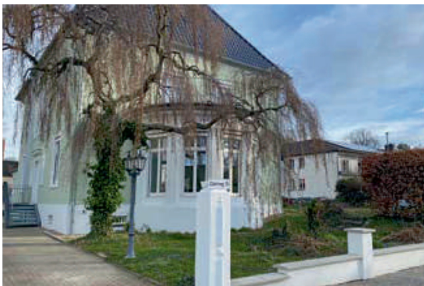
Die IHK Zweigstelle Hamm am Ostring 15 ist in einem stilvollen Gebäude untergebracht. Die Modernisierungs- und Renovierungsarbeiten rund ums Haus sind so gut wie abgeschlossen – ergänzt wird es noch um eine barrierefreie Rampe. Foto: IHK
