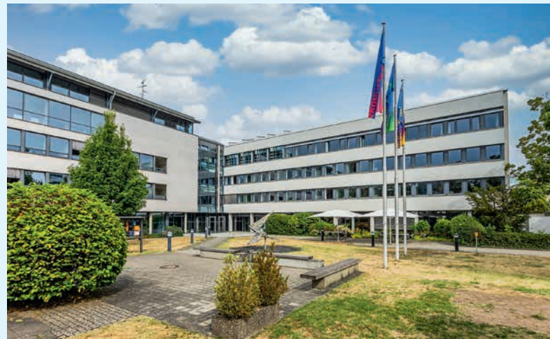
Der Gebäudetrakt aus den 90er-Jahren (links) soll kernsaniert werden, die beiden Gebäudeteile aus den 60er- und 70er-Jahren (rechts im Bild und verdeckt dahinterliegend) werden abgerissen. Foto: Dennis Möbus
