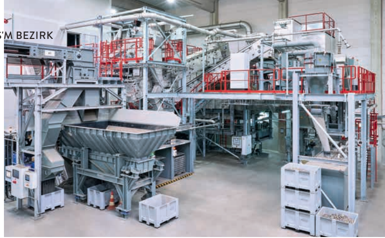
Die Anlage recycelt Haushaltsbatterien, die etwa in Fernbedienungen oder Taschenlampen verwendet werden.
