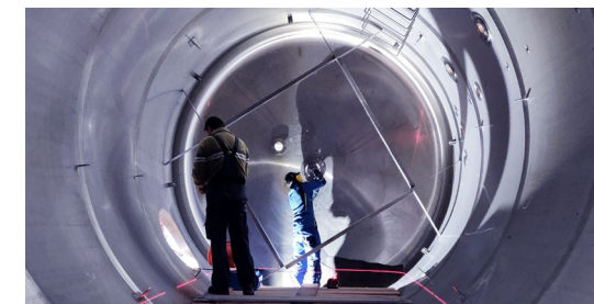
WindNODE, Dresden FLÜSSIGESPEICHER FÜR POWER TO COLD - ANWENDUNGEN
