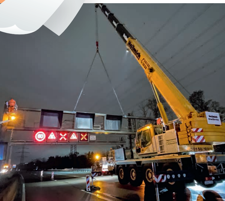
Ein Kran kommt zum Einsatz, um eine alte Schilderbrücke auf der A5 zu demontieren. Foto: Michael Findeiß
