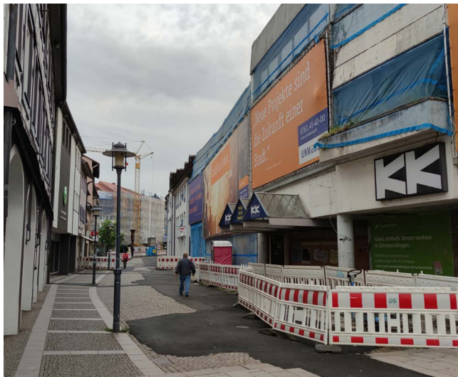
© Ermendingen, Umbau der Innenstadt 2021, Foto: Thomas Kaiser
