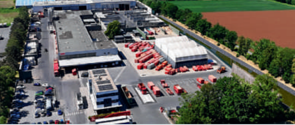
An der Capeller Straße in Werne wird sich die RCS-Gruppe in nördlicher Richtung erweitern, um Recycling und Kreislaufwirtschaft weiter voranzutreiben. Foto: RCS
