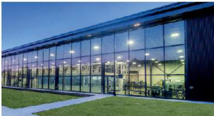
Die Fenster des neuen Gebäudes sind mit speziellem „Smart Glass“ ausgestattet. Damit lassen sich Einblick und UV-Einstrahlung steuern.
