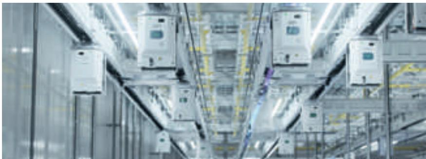
Mit hoher Übertragungsfrequenz, geringer Stromstärke und einem minimalen Magnetfeld will die VAHLE-Technologie hohe Energieeffizienz beim innerbetrieblichen Materialfluss in der Halbleiterfertigung bieten. Foto: VAHLE
