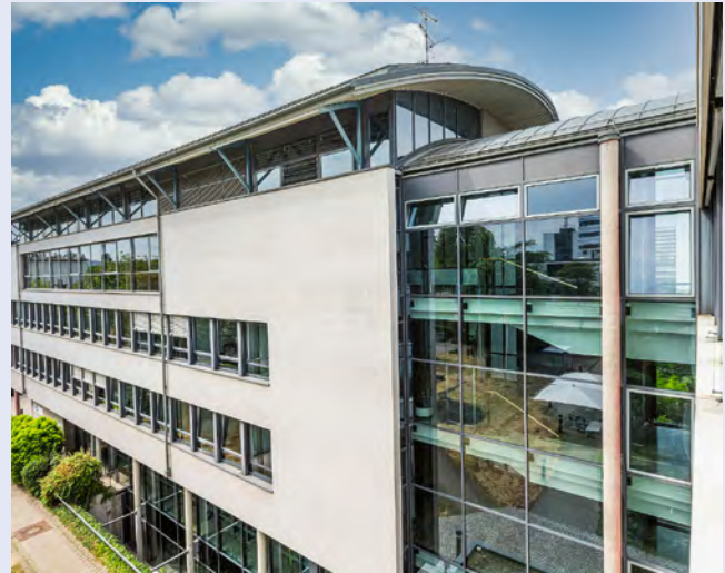
Der Gebäudeteil aus dem Jahr 1994 soll künftig ausschließlich als Bürogebäude genutzt werden. Foto: Dennis Möbus
