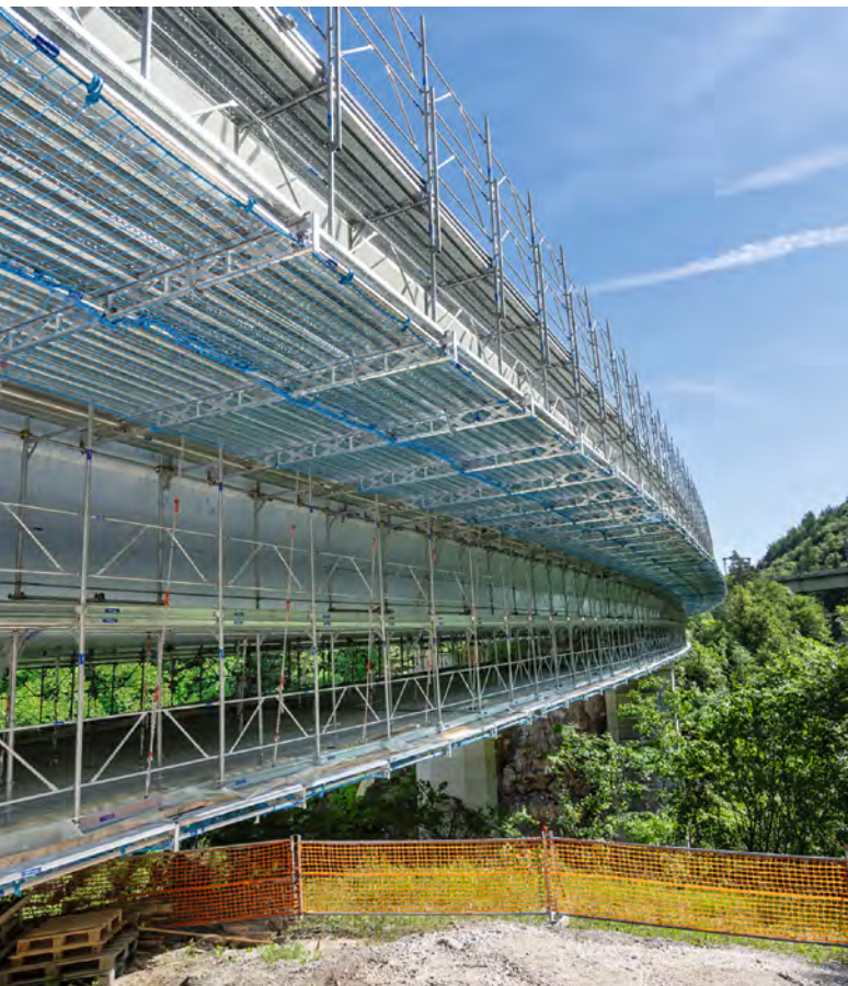
Ein großer Vorteil von Flydeck-Systemen ist, dass während der Sanierungsarbeiten an Brücken keine Fahrspuren gesperrt werden müssen. Foto: Flydeck-Systeme
