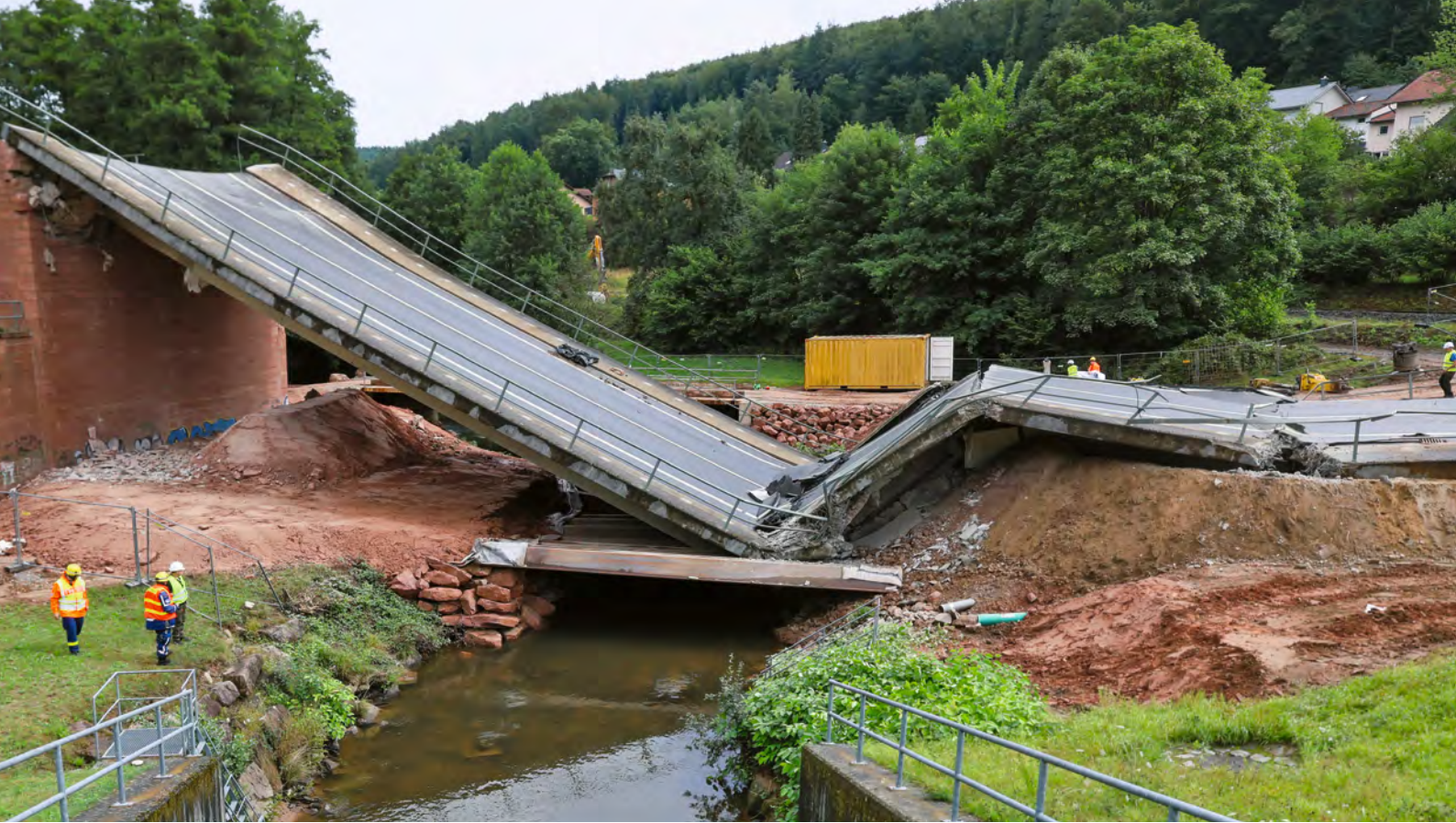
Punktlandung: Die Zeller Brücke ist am 30. Juli wie geplant niedergelegt worden. Foto: Guido Schiek
