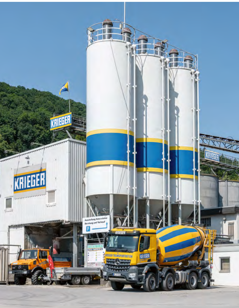
Am Umschlagplatz in Neckarsteinach betreibt die Krieger-Gruppe ein Transportbetonwerk. Foto: Krieger
