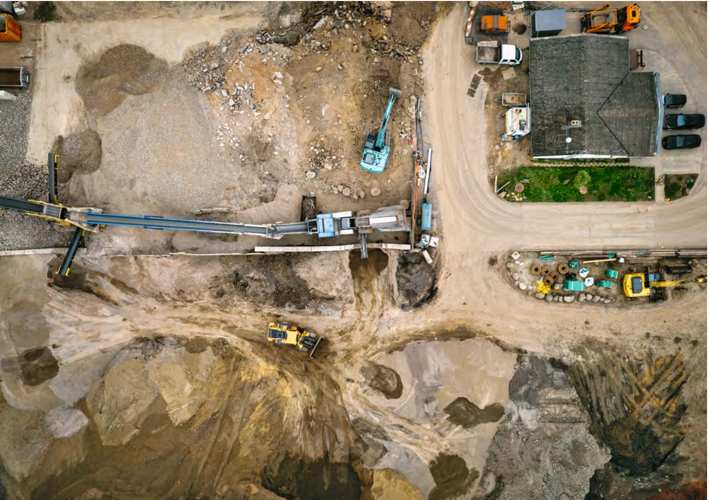
Wie in einem riesengroßen Sandkasten: Auf dem Betriebsgelände von 360 Materials in Rüsselsheim werden Wertstoffe recycelt. Foto: 360 Materials
