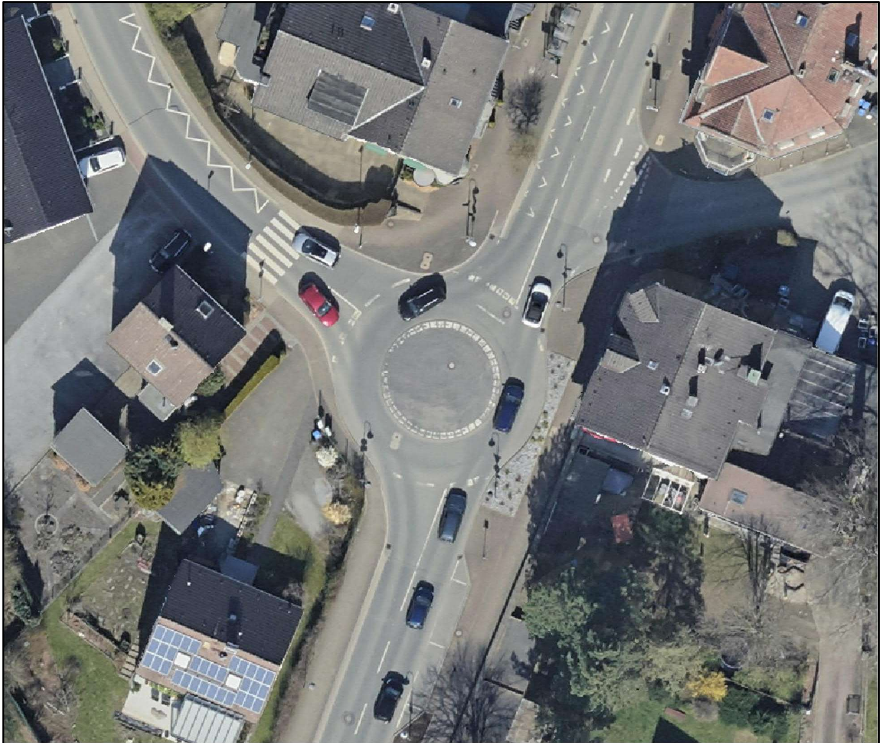
Abbildung 5: Luftbild des Kreisverkehrs Bahnhofstraße / Hauptstraße (L 70) [7]
