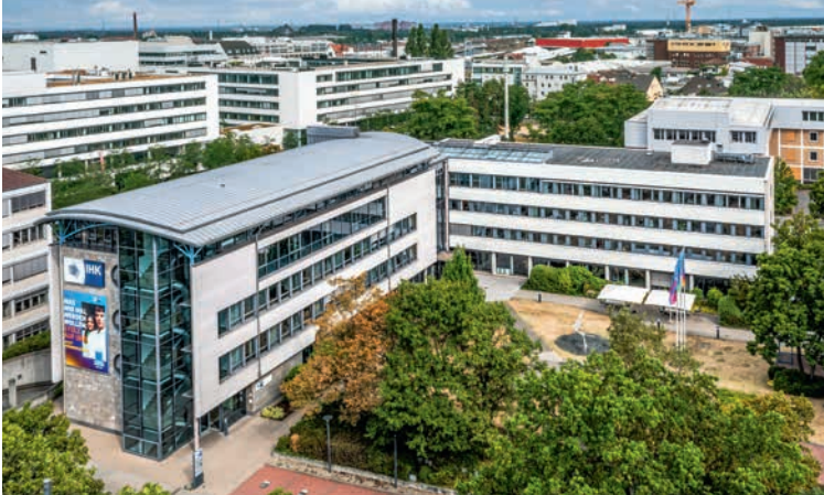
Der Gebäudekomplex der IHK Darmstadt in der Rheinstraße 89 ist in die Jahre gekommen. Foto: Dennis Möbus
