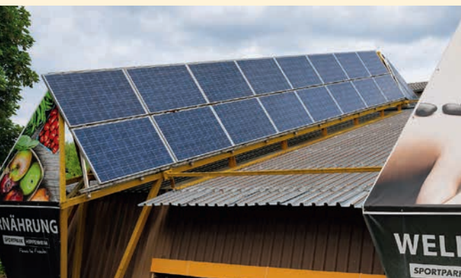
Die großen Dächer der Hallen eignen sich gut zur Stromerzeugung.
