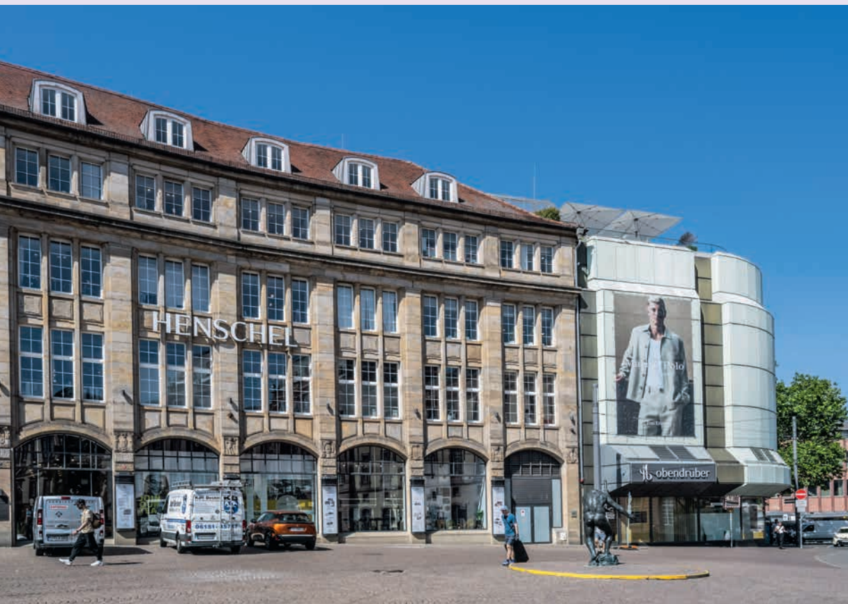
Das markante Kaufhaus, in dem Henschel in Darmstadt untergebracht ist, wurde in zwei Bauabschnitten (1908 und 1913/14) errichtet. Die gerasterte Fassade aus gelbem Sandstein setzt am Marktplatz Akzente.
