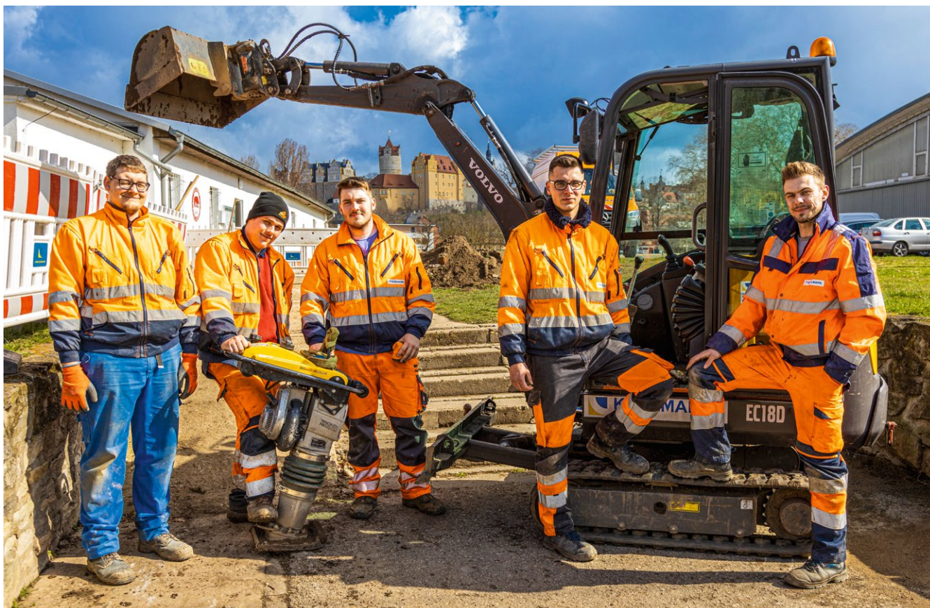
Bei der Azubi-Baustelle legten die Auszubildenden aus dem dritten Lehrjahr der Kuhlmann Leitungsbau GmbH & Co. KG eigenständig einen Hausanschluss. Profitiert hat davon der SV Einheit Bernburg.
