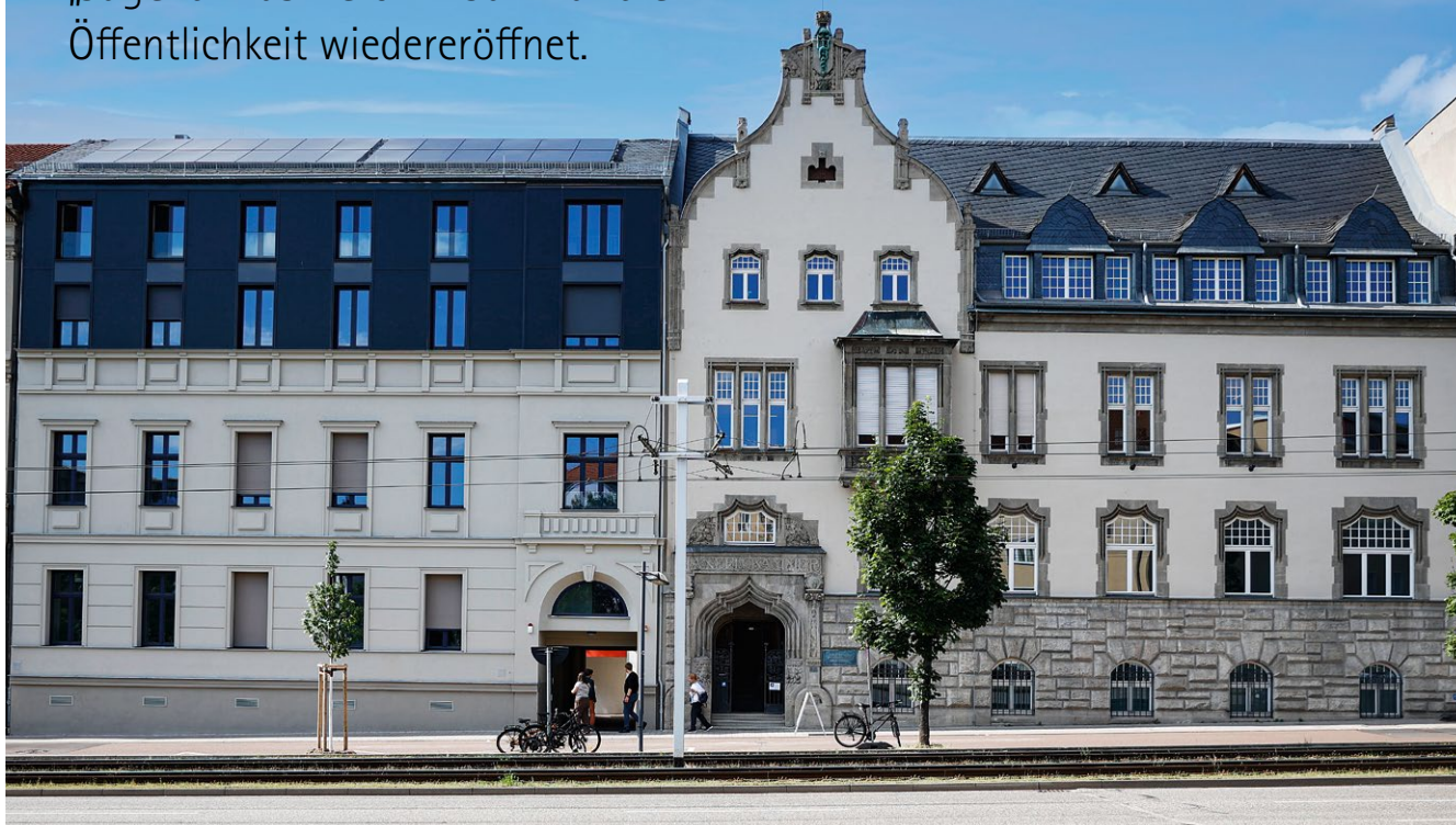
Blick auf die renovierte Fassade des IHK-Gebäudes mit Photovoltaikanlage auf dem Dach.
