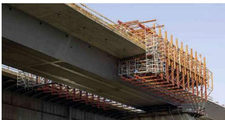
Vereinfachter, hydraulisch betriebener Schalwagen für großtechnischen Einsatz.
