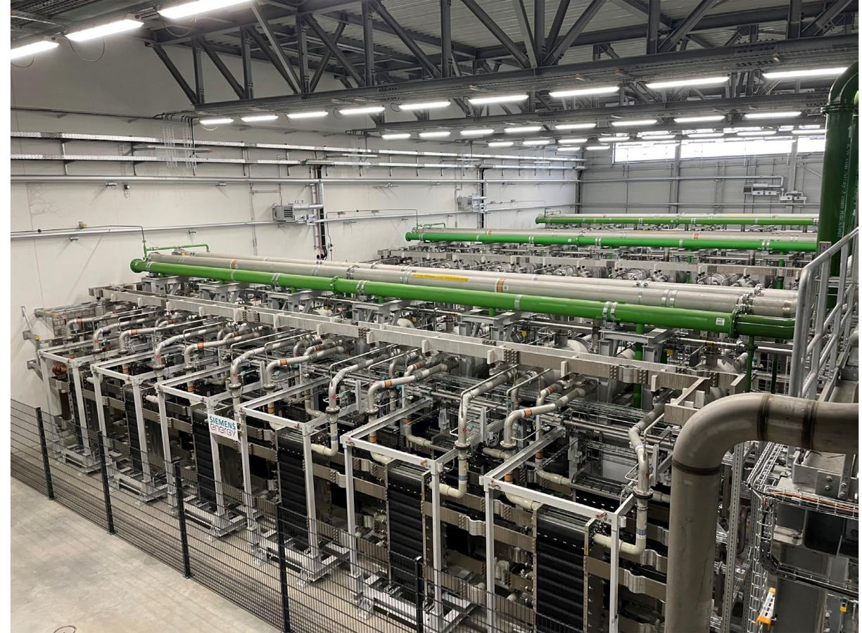
3 Arrays = 54 MW  $\approx$  1t Wasserstoff pro Stunde
