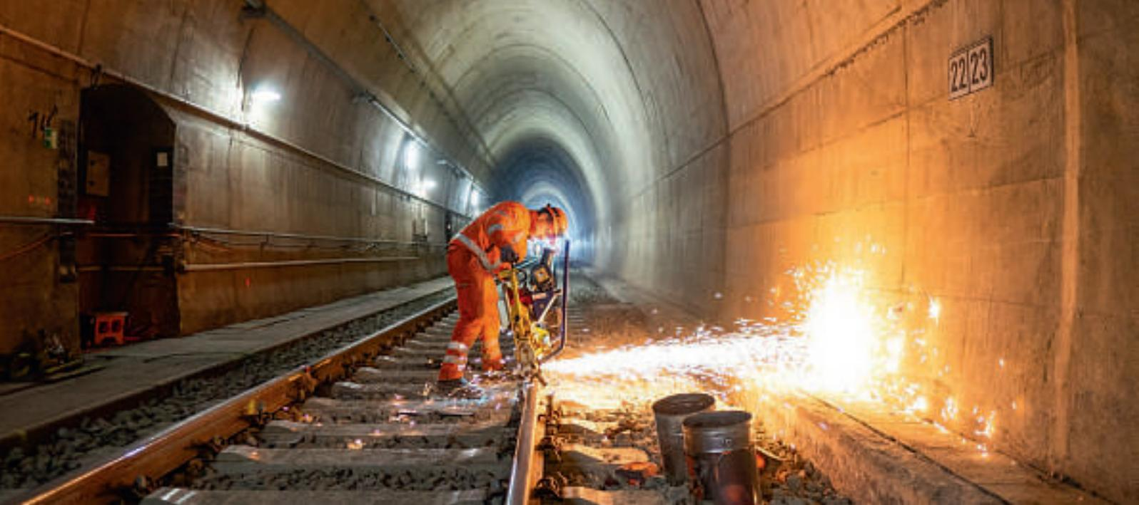
Ein Mitarbeiter aus der Abteilung Oberbauschweißen führt Schleifarbeiten an einem Schienenstoß in einem Tunnel in Olpe durch. Das Unternehmen Klostermann in Hamm hat sich bundesweit einen Namen gemacht in Eisenbahn-, Tief- und Ingenieurbau.
