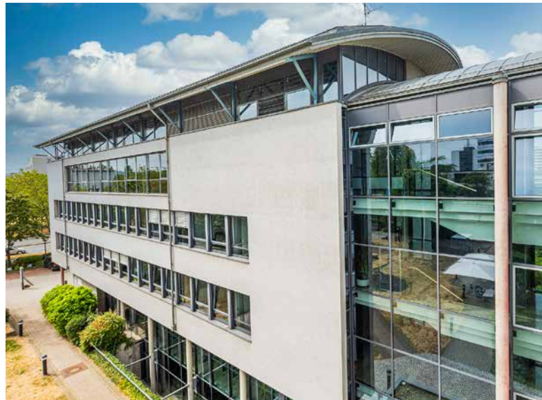
Der Gebäudeteil aus dem Jahr 1994 kann saniert werden. Foto: Dennis Möbus
