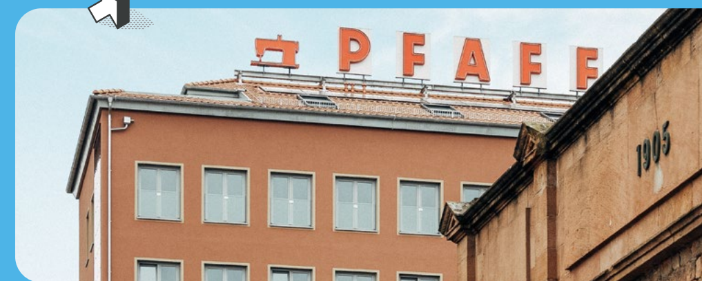
Altes Verwaltungsgebäude und Teil einer alten Pfaff-Produktionshalle
