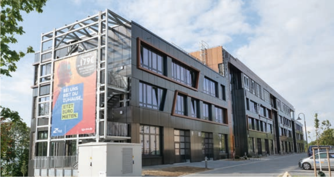
◀ Das neue Haus 7 des TGZ Schwerin/Wismar in der Hagenower Straße in Schwerin.
