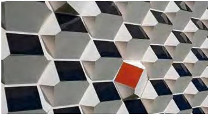
Die hochkomplexe und futuristische Sichtbetonfassade wurde von HERING entworfen und im eigenen Fertigteilwerk produziert. Ende April fand das Abschlusstreffen des Forschungsteams an der Demonstrator-Fassade bei HERING in Burbach-Holzhausen statt.
