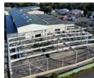
Klassischer Industriebau in Stahl: Erweiterung des Werksgeländes eines Fenster- und Türenherstellers um eine zusätzliche Produktionshalle. (Foto: Otto Blecher GmbH)
