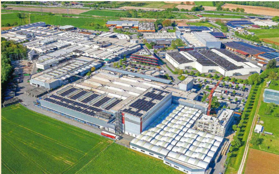
Solar auf dem Dach, Wind vor der Nase: die Fischer Group in Achern-Fautenbach
