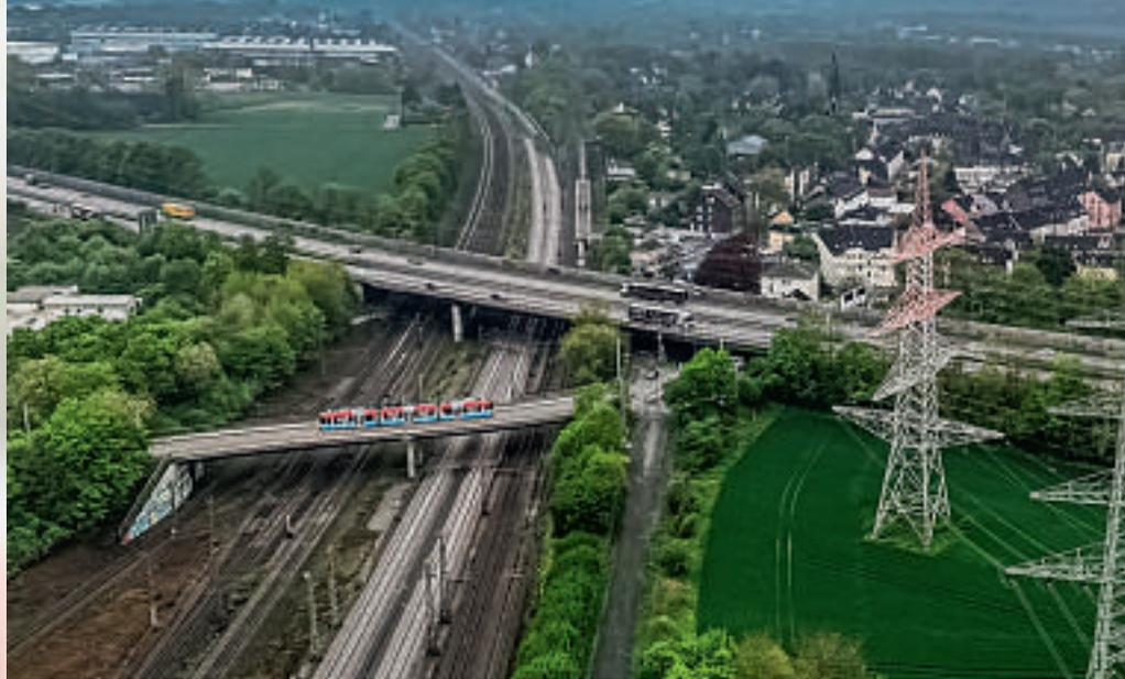
**Blick auf einen Brückenkomplex aus dem Jahr 1971 im Bereich Dortmund West über der Martener Straße. Mit Traglastindex V ein Sanierungsfall. Bauarbeiten an diesem Komplex hätten aufgrund seiner Lage erhebliche Auswirkungen auf das gesamte Verkehrsnetz.**
